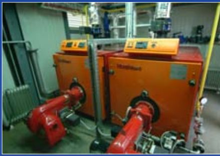
MOL Rt. (Ásotthalom) 400 kW-os kazánkonténer 2 db Hoval MAX-3 400 melegvíz kazánnal
