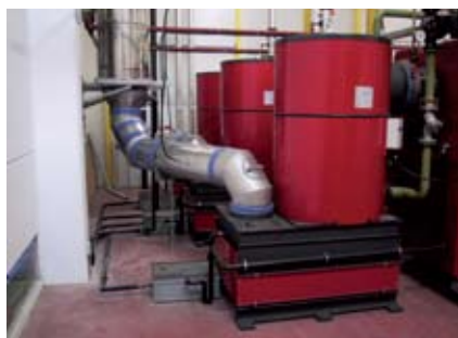
Szerelési példa: 3 db ThermoCondensor aluFer® (1100) a Julius Blum GmbH-nál Fussach-ban (A)
