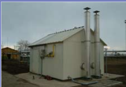
MOL Rt. (Kardoskút) 500 kW-os kazánkonténer 2 db Hoval MAX-3 245 melegvíz kazánnal
